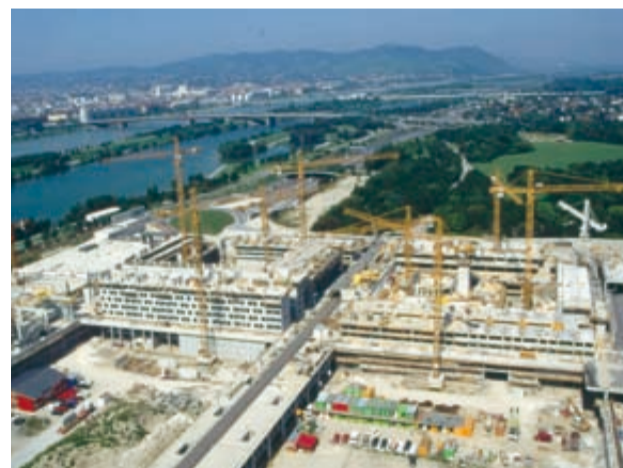
Beim Bau der Wiener Donau City erhielt Katzenberger mit je rund 100.000 Quadratmetern den bisher größten Auftrag für Doppelwände und Elementdecken
