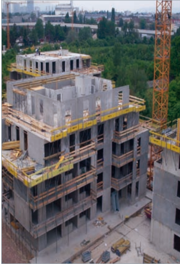
MABA FTI produzierte im ersten Halbjahr Wände, Decken, Treppen, Liftschächte und Balkonplatten für drei Wiener Großbauvorhaben
