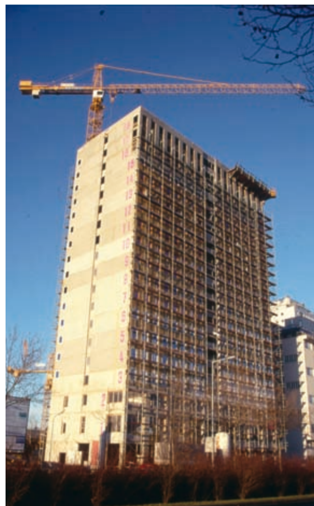
Die statischen Möglichkeiten des Doppelwand-Systems lassen Gebäude mit bis zu 25 Stockwerken zu
