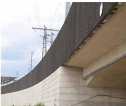
Verankerungslaschen an der Stützmauer-Krone. Weitere 110 Quadratmeter wurden hängend mit Hilfe eingebauter Stahlkonsolen oben und Ankerschienen im unteren Bereich versetzt.
